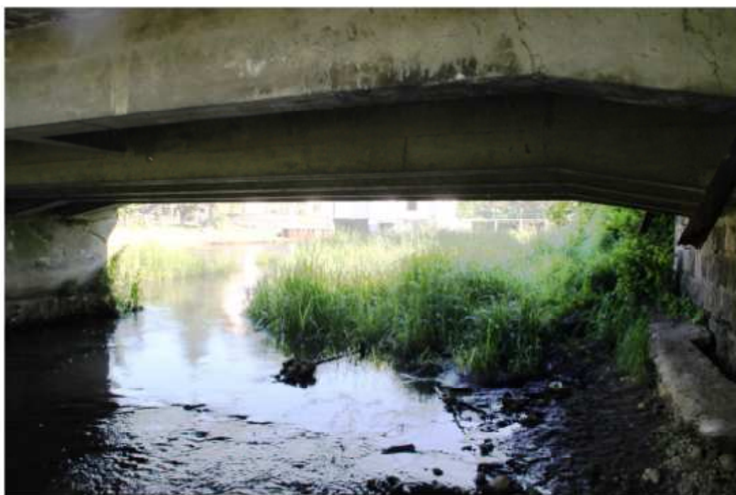
Widok zanieczyszczeń, zamulenia koryta rzeki przy przyczółku lewym(fotka górna) Widok zanieczyszczeń koryta rzeki w obrębie przyczółka prawego na wylocie(połamane i zalegające w korycie rzeki drzewa)
