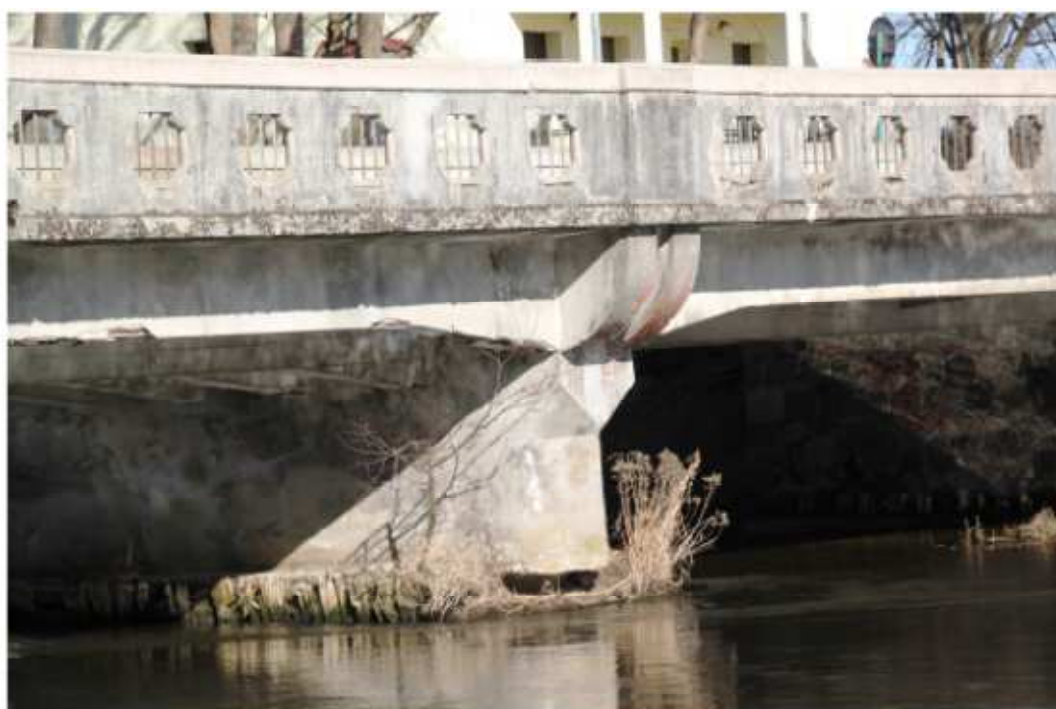
Widok uszkodzeń, ubytków i karbonatyzacji filara 1.2 od strony górnej wody, na styku przepływu wody spowodowanych między innymi złym stanem utrzymania koryta rzeki w obrębie mostu.
