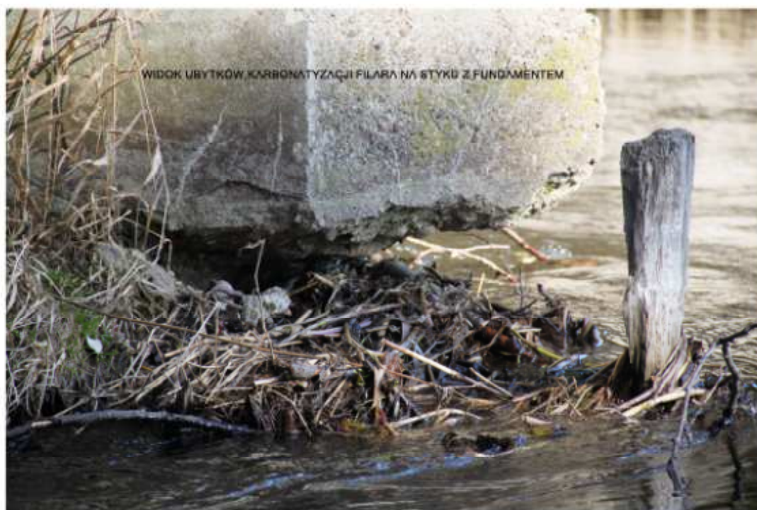
Widok uszkodzeń, ubytków i karbonatyzacji filara 1.2 od strony górnej wody, na styku przepływu wody spowodowanych między innymi złym stanem utrzymania koryta rzeki w obrębie mostu.
