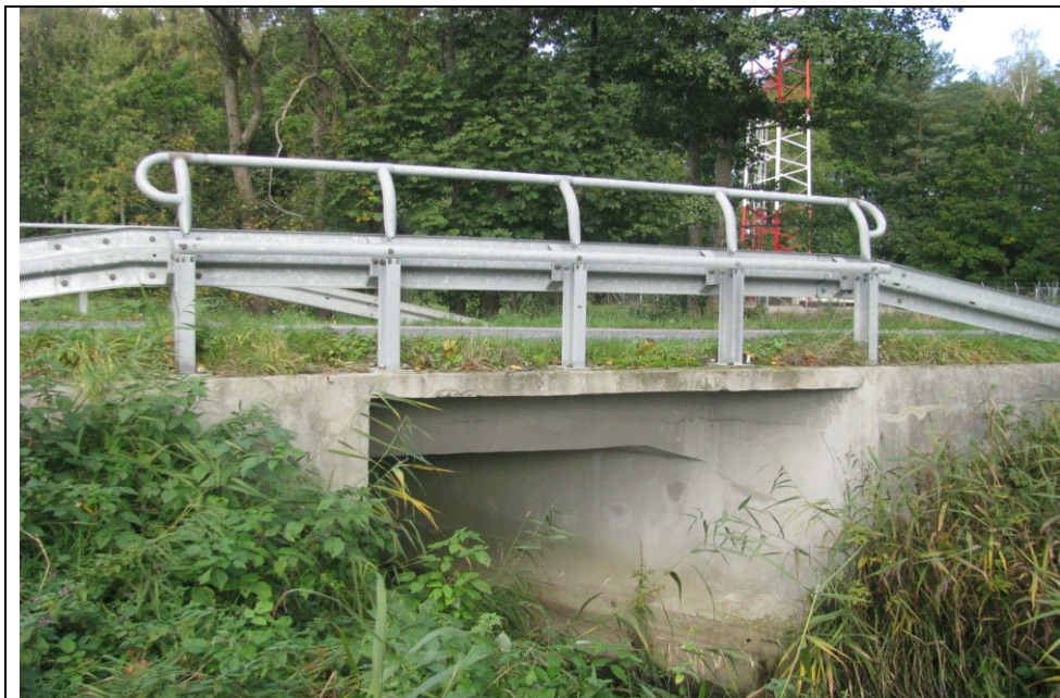
Fot. 1. Widok mostu z boku - od dolnej wody.
