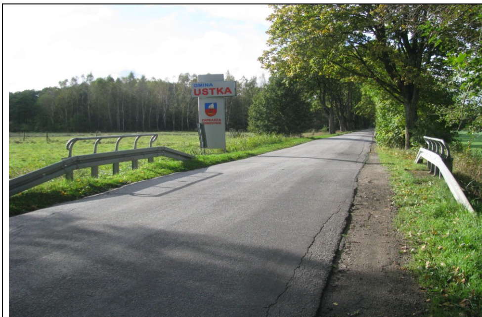
Fot. 2. Widok mostu od strony dojazdu – kierunek Bydlino.
